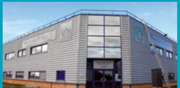
La maison médicale de Fyé bénéficie de travaux d'extension
