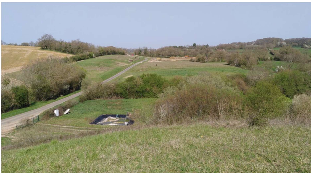
Vue depuis le casier 1 vers l'entrée du site au nord
